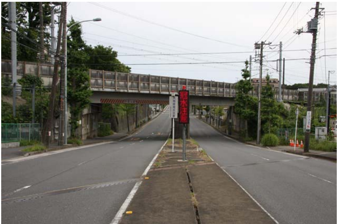
環状2号線側から
